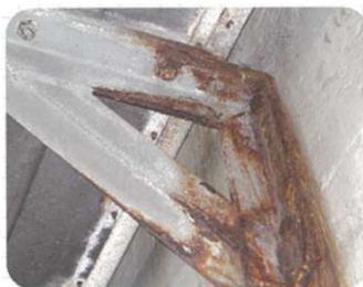
亜鉛メッキ鋼材のサビ状況
