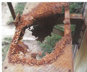
鋼製検査路 腐食部
