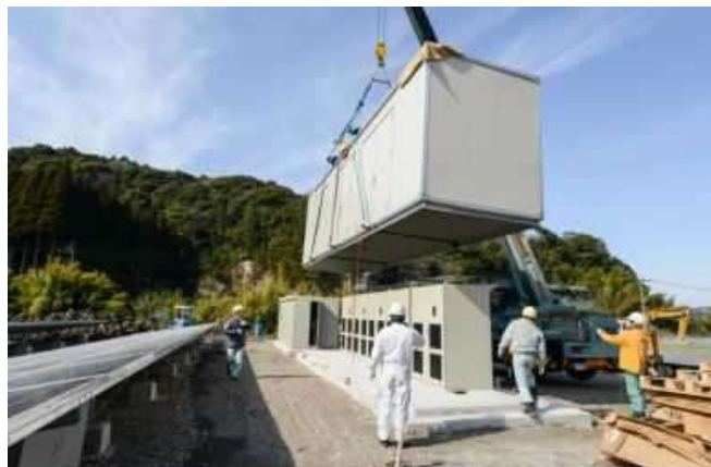
クレーンで吊上げ
