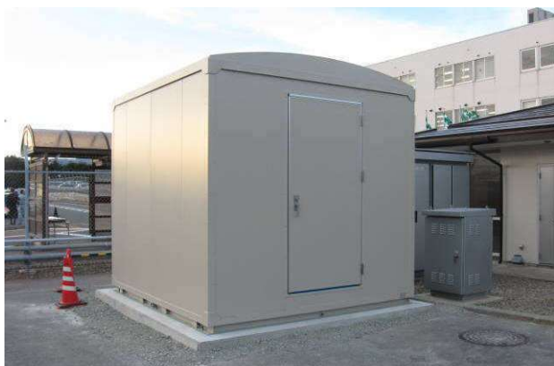
特殊屋根 機器收容局舎
