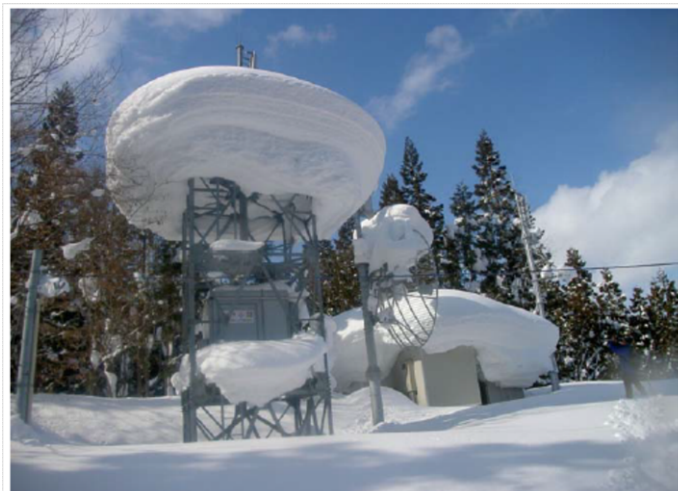
1) 日本有数の豪雪地帯にある電気通信機器収容局舎
