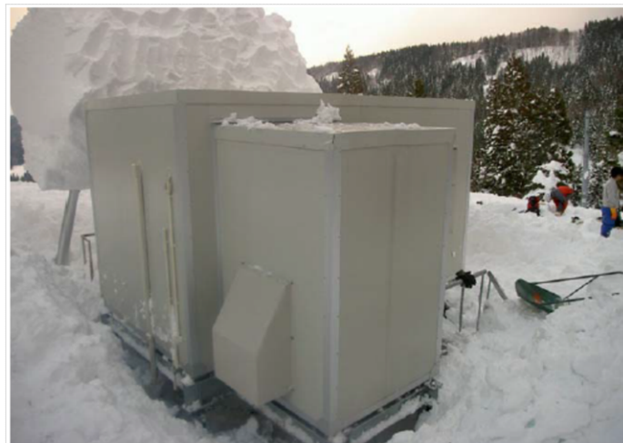
6) 雪下ろし作業完了 局舎は殆どダメージなし。
