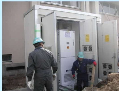
5. 局舎内へ設置
