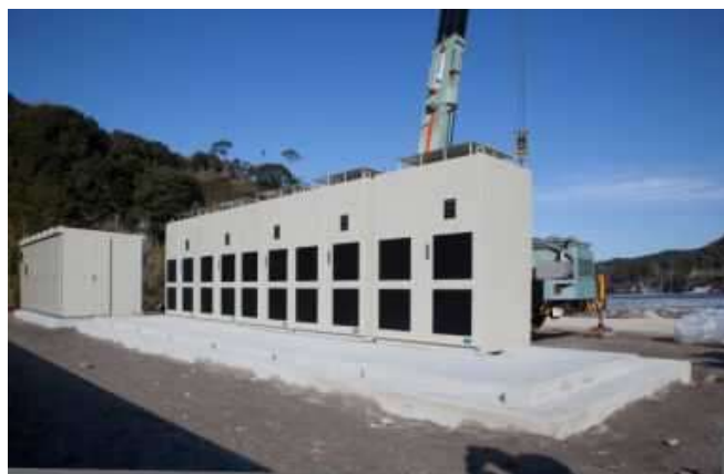
PVインバーター据付
