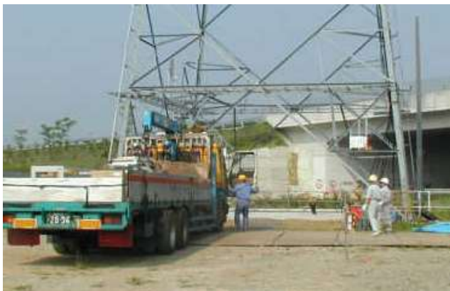
局舎部材を現場へ搬入
