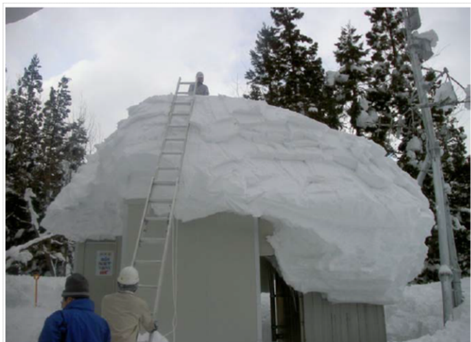
5) 屋根の雪下ろし
