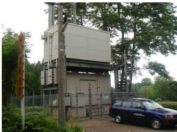
架台併用二段設置 機器收容局舎
