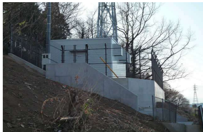
消防防災無線機 機器収容局舎
