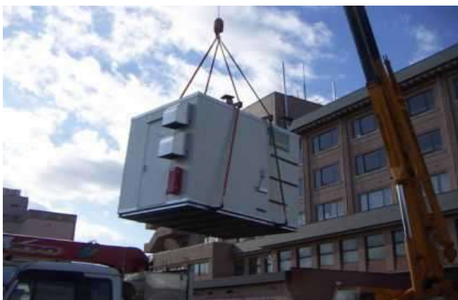
クレーンで吊上げ
