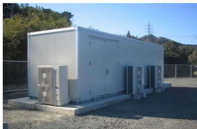
電気通信 機器収容局舎
