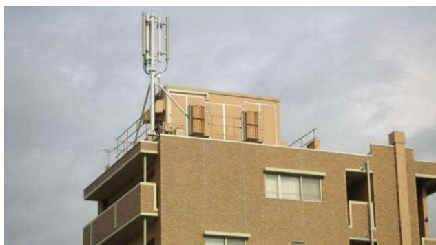
環境色対応 機器收容局舎
