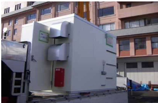
完成局舎を現場へ搬入
