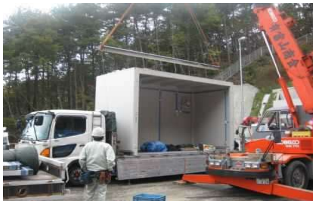
分割ユニットを現場へ搬入
