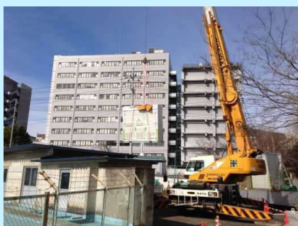
2. クレーンで吊上げ
