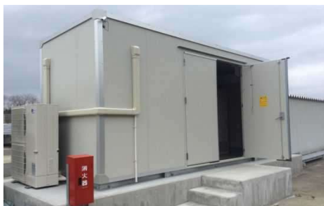
電気通信 機器収容局舎
