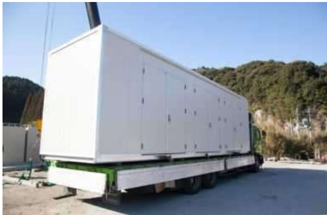
完成局舎を現場へ搬入
