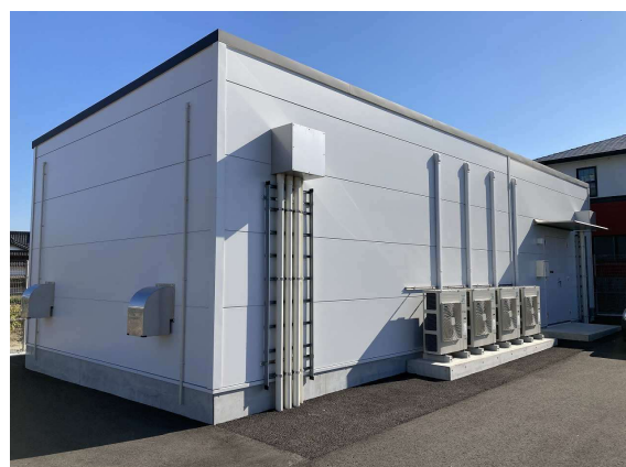
鉄骨造大型 機器收容局舎
