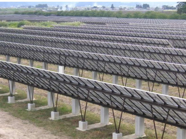
岩手県メガソーラー_地上 (CSフレーム)
