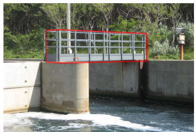
点検路（発電所水路）
