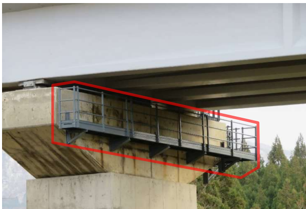
自動車専用道路橋脚
