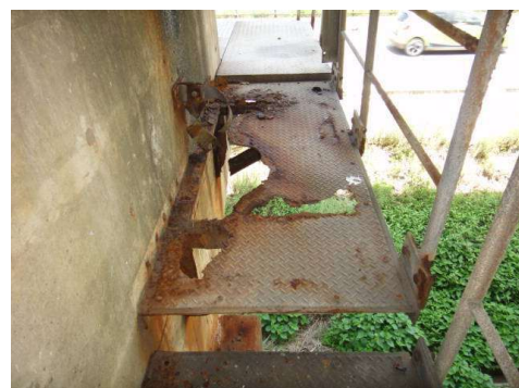
鋼製フレーム検査路
