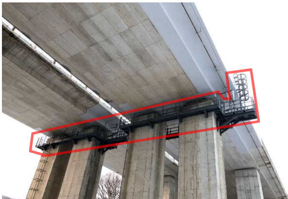
自動車専用道路橋脚
