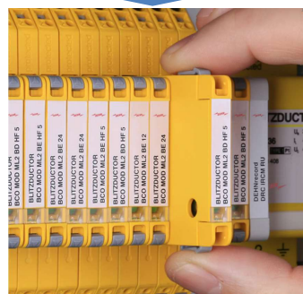
モジュール交換
