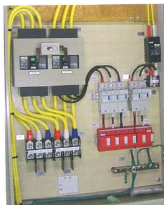
SPD内蔵引込開閉器盤 (設置例)
